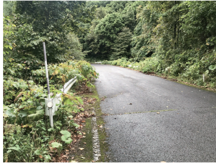
除草作業前の町道高家領袖山線
