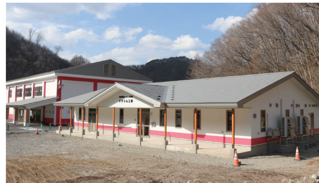
高齢者福祉センターの隣に完成したすずらん工房の新施設
