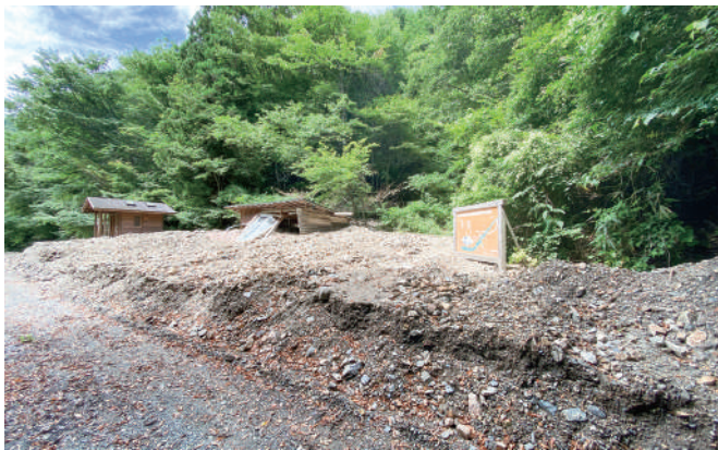
歩道へ土砂が流れ込んだ七滝周辺
