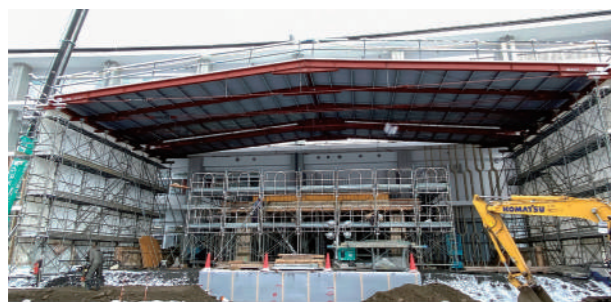
町道茶屋場田子線につながる 工事中の新庁舎南側エントランス
