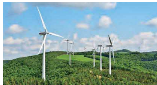
グリーンパワーくずまき風力発電所
