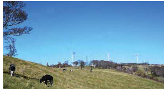
エコワールドくずまき風力発電所 (令和元年8月末廃止)
