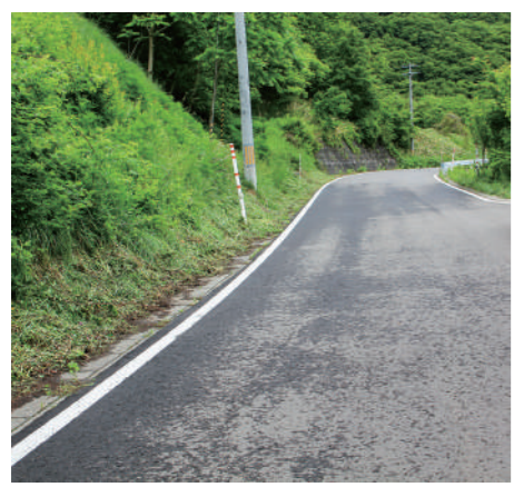
長寿命化工事後の町道坂待屋鷹ノ巣線
