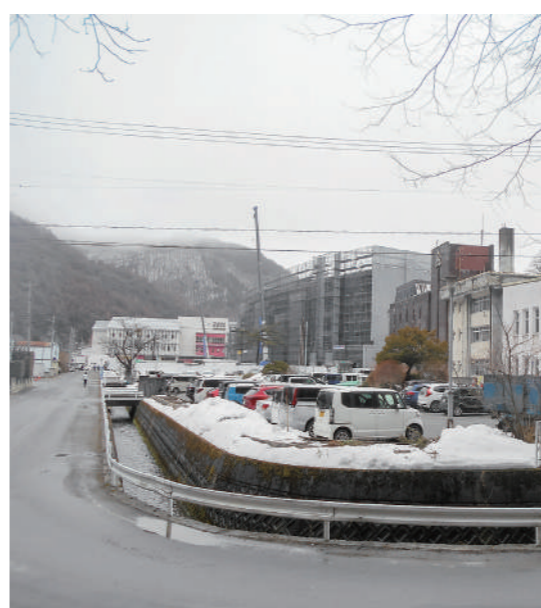
ハブ機能が期待される工事中の新庁舎 (中央)
