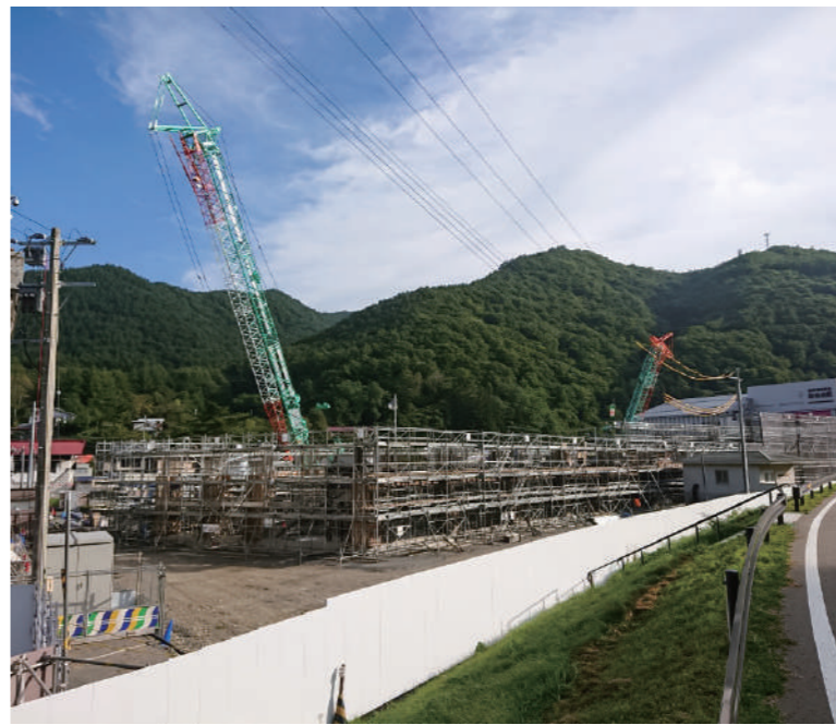
順調に進む新庁舎建設工事
