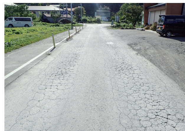
修繕工事を行う五日市袖山線
