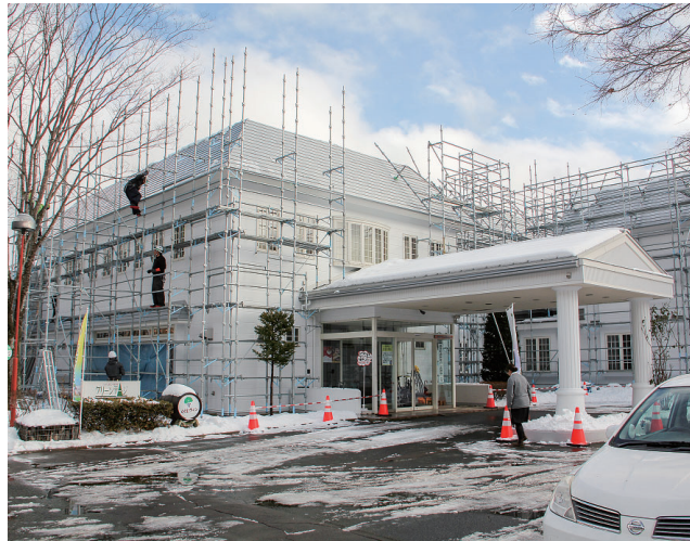
改修工事中のグリーンテージ
