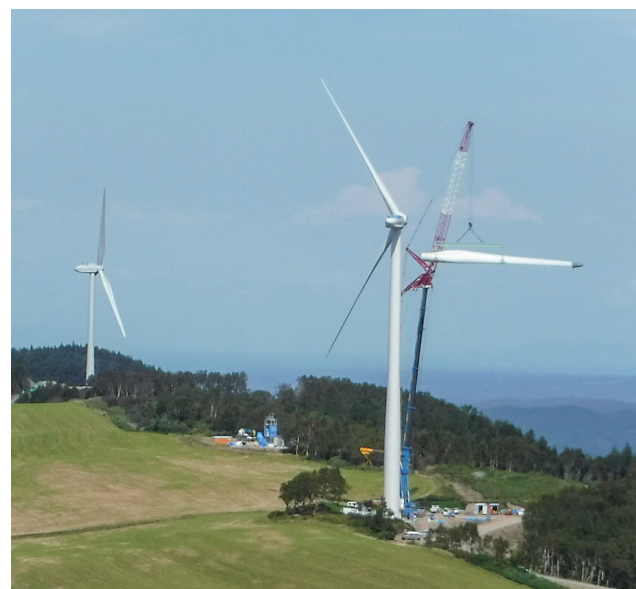
建設工事中のくずまき第二風力発電所
