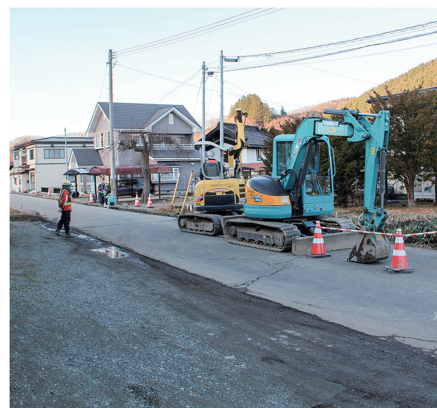
完成に向けて工事が進む江刈地区水道(中村地区)
