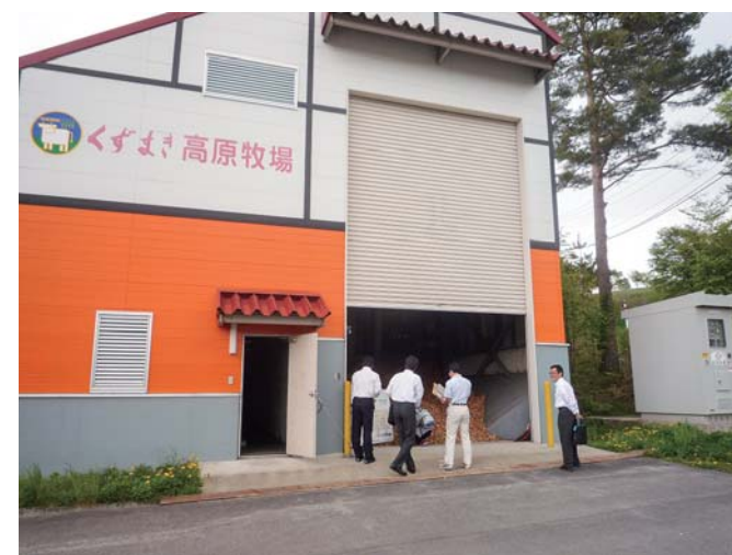
くずまき高原牧場内にある木質バイオマス発電施設
