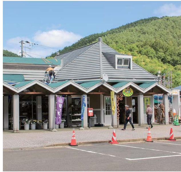
改修中の「産直ハウスくずまき高原」
