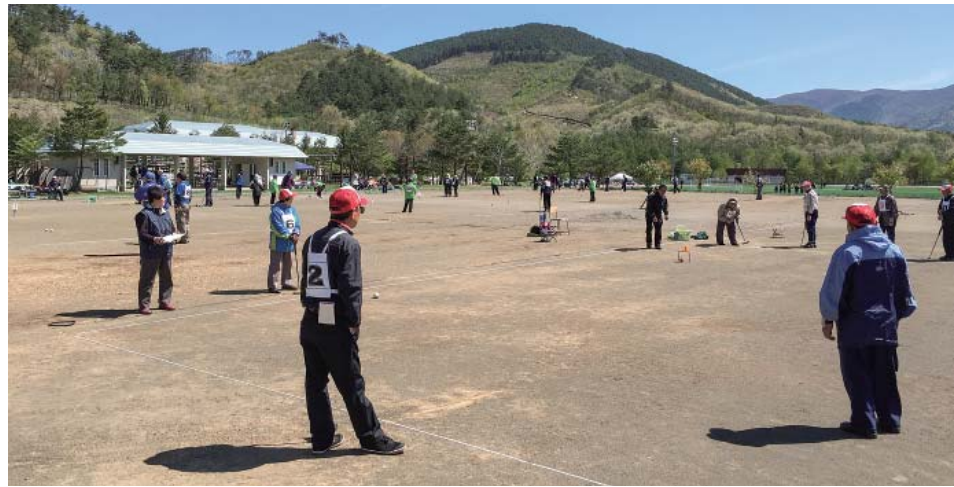
改修工事を行うゲートボールコート
