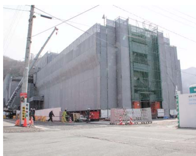
建設が進む新葛巻病院
