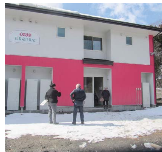
新たに整備した小田地区若者定住住宅
