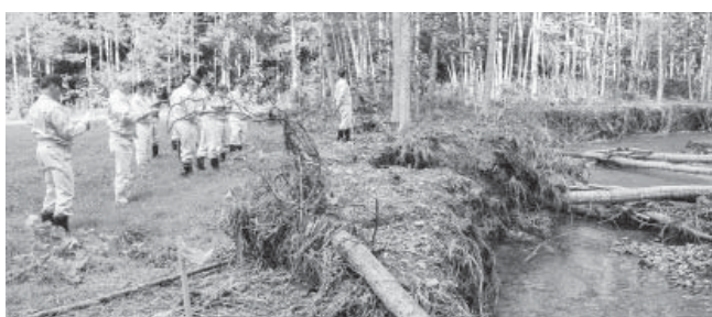
台風10号による被害箇所を確認する議員（上外川地区）
