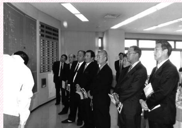
電源開発株の集中制御室
