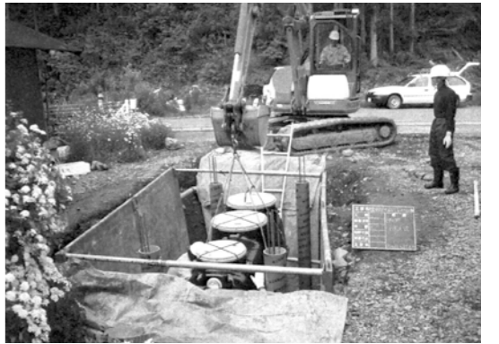
合併浄化槽設置工事
