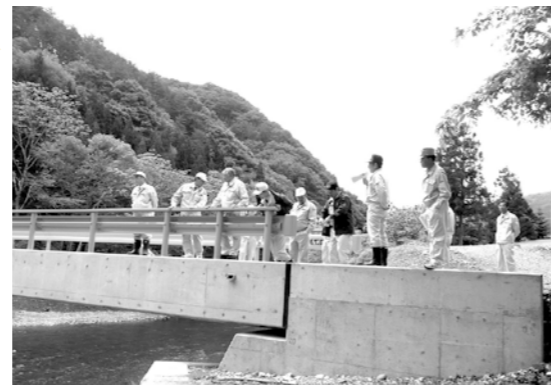
⑥吊り橋が永久橋へ(前里橋、町営)
