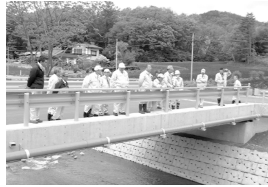
④岩瀬張橋(県営)
