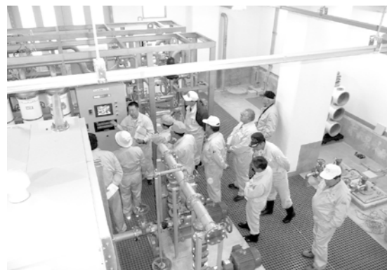
⑨小屋瀬・元木地区の送水場完成。
