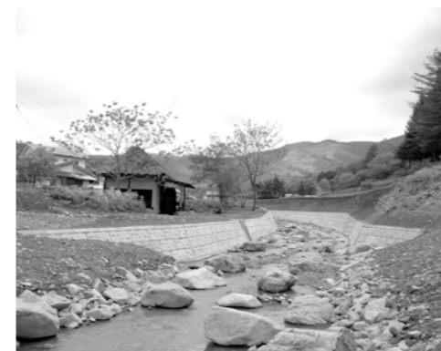
③元町川災害関連工事(県営)
