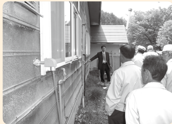
外壁を張り替える小屋瀬保育園
