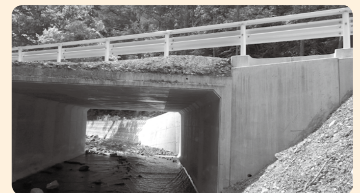
災害防止を考慮したボックス構造で根地戸線に架けられた橋
