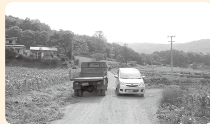
打田内から葛巻林業方面へ舗装される野中線
