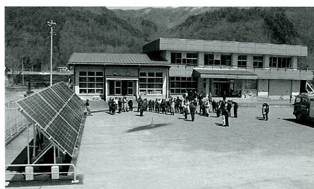
太陽光発電施設を整備した江刈農村センター
