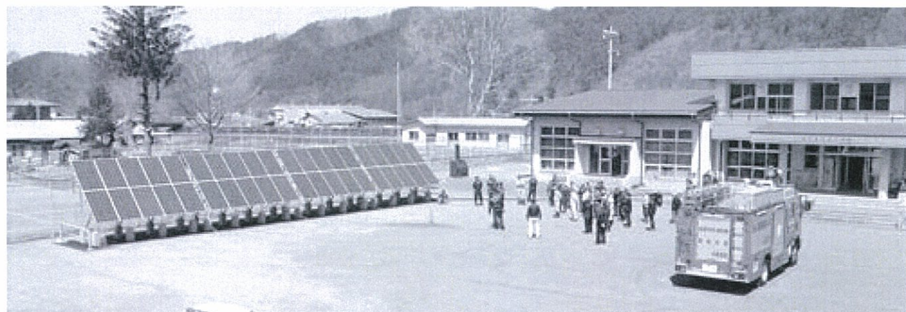
町内25カ所の地区センターに整備された太陽光発電設備（江刈農村センター）
