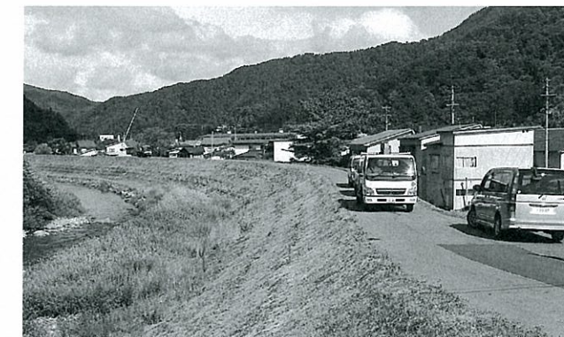
早期整備が望まれる馬淵川河川堤防
