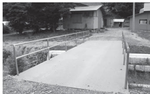
単管パイプを活用した手すりを設置した橋（江刈小屋瀬）
