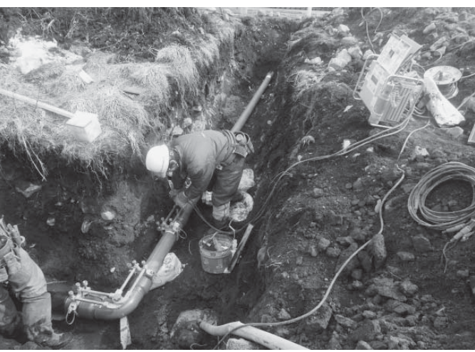
新たな水道管の設置工事が進む橋場地区
