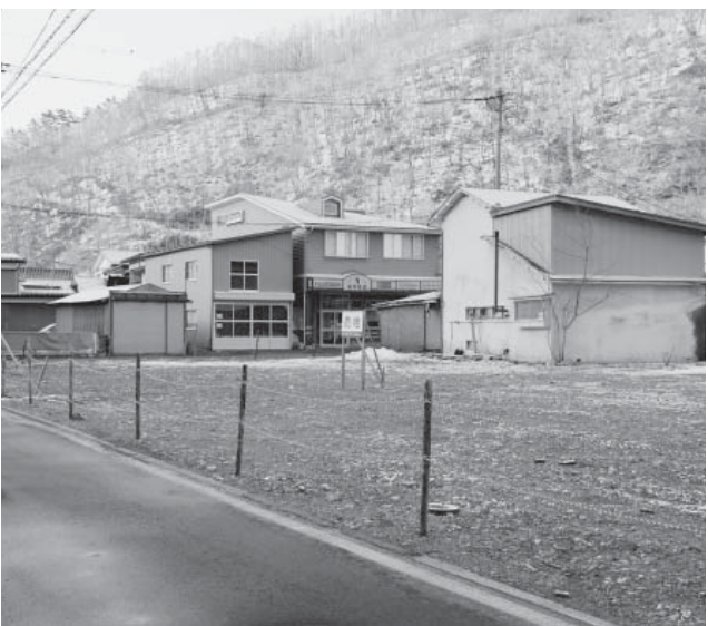
空き家が約40戸に増加した町中心部の新町地区
