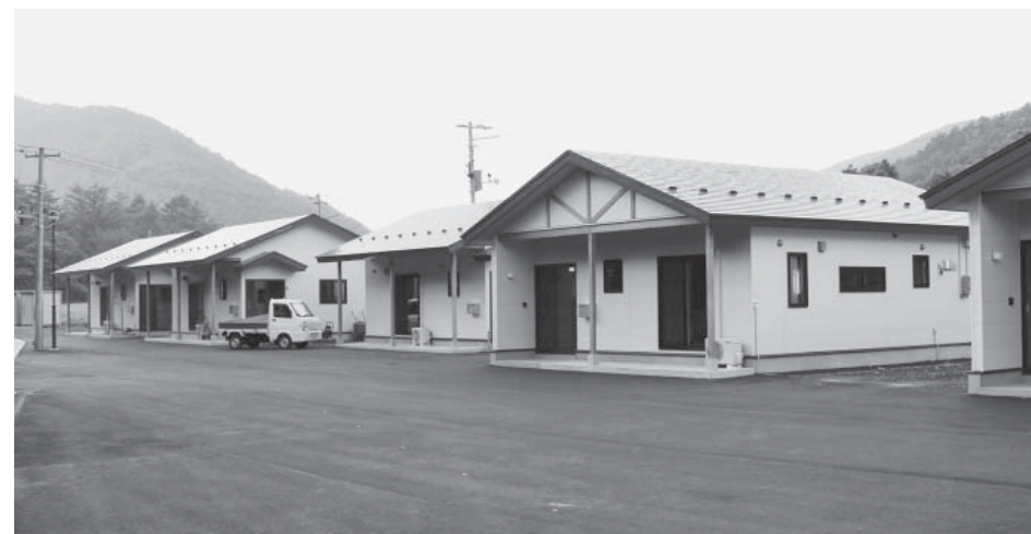
单身と家族向けの住宅を3棟ずつ整備した町営小屋瀬住宅
