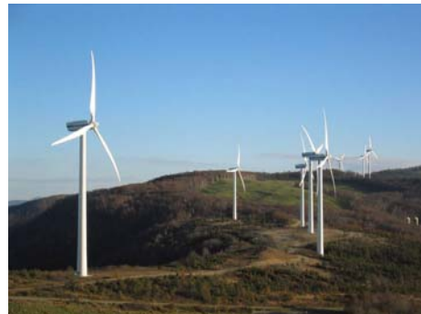
グリーンパワーくずまき風力発電所
