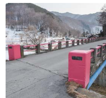
▲老朽化が進む大橋の架け替えを含めた道路の幅を広げる工事を行い安全性や快適性、利便性の向上に努めます
