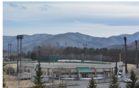
▲10月2日～4日、当町で行われる希望郷いわて国体の軟式野球競技。その会場となる総合運動公園野球場の改修工事を行います
