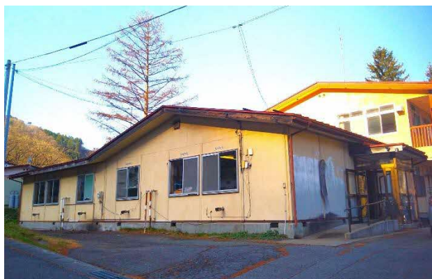
解体予定の旧公団宿舎
