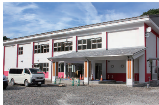
完成間近の高齢者福祉センター
