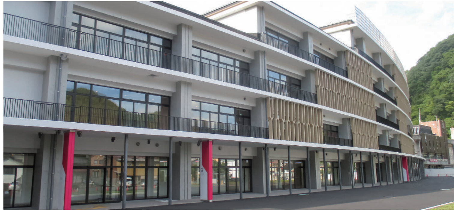
新たな町の拠点となる新庁舎の完成
