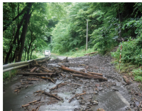
土砂や木が流出した町道毛頭沢線
