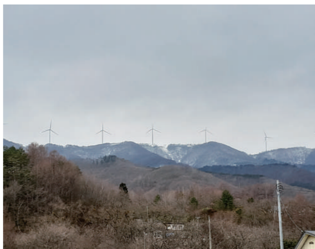
固定資産税の増が見込まれる風力発電施設
