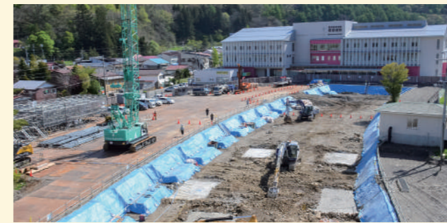
新庁舎建設工事着工 (3月※写真は5月の工事現場の様子)
