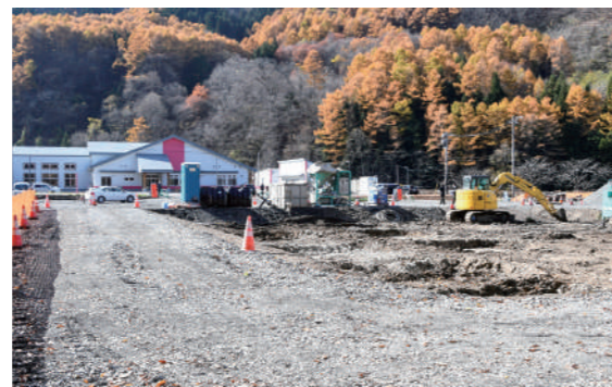
整備工事が進む高齢者福祉施設
