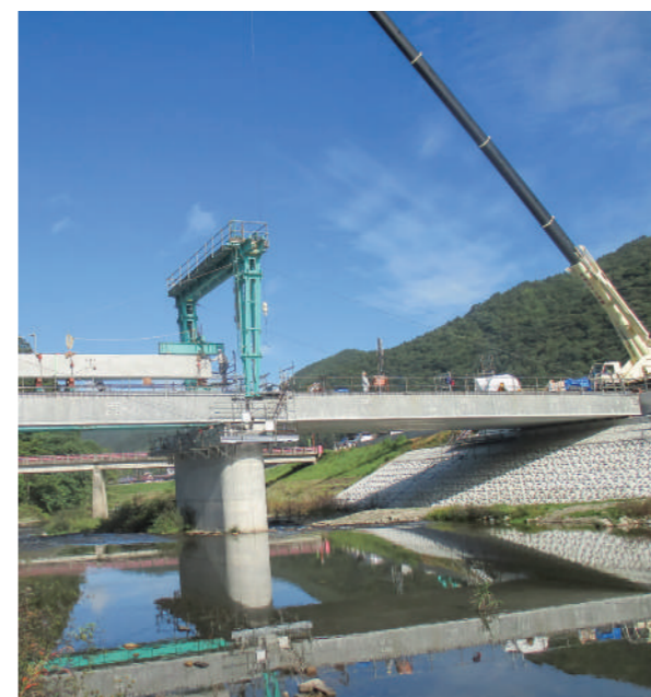
橋桁の設置が進む大橋架替工事
