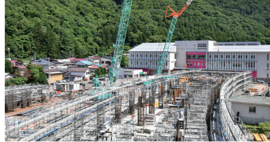
建設工事の中の新庁舎
