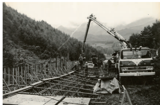
五日市から袖山へ続く道路の整備
