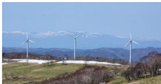
平成11年、袖山に完成した最初の風力発電施設（令和元年に事業終了）
