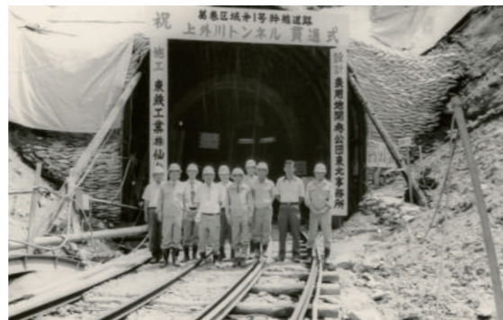
昭和53年の上外川トンネルの貫通の様子
