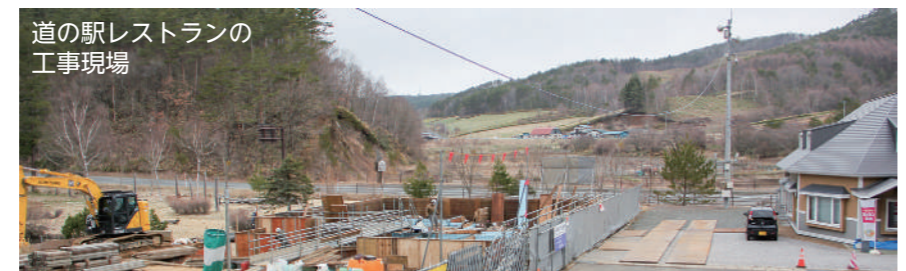
道の駅レストランの工事現場
