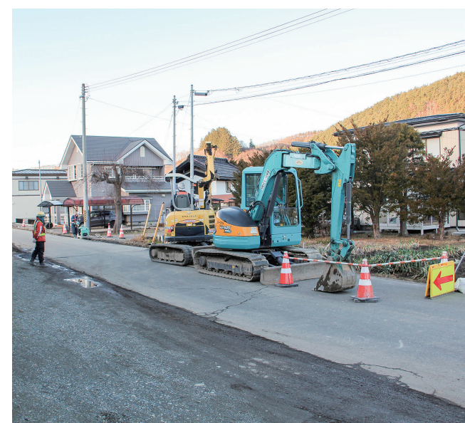
江刈地区での水道整備工事
