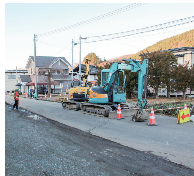
江刈地区での水道整備工事
