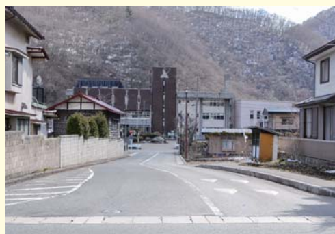
町道役場線。幹線道路や生活関連道路網について整備の促進や維持管理体制の充実を図ります。
