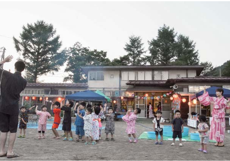
五日市保育園の夏祭り。園舎は築48年経過し老朽化しています。
