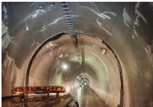
点検予定の上下川トンネル
