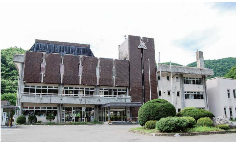
築42年経過している役場庁舎。新庁舎は町の中核機能を発揮することが期待されます。
