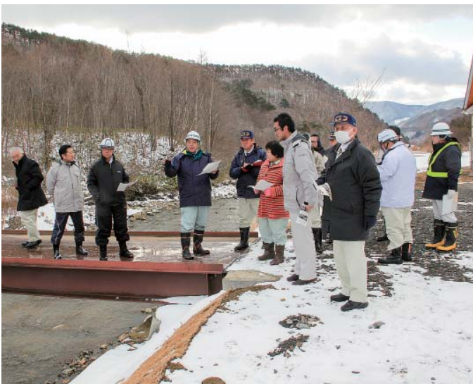
災害復旧した岩瀬張地区。元町川は急傾斜のため流れが速いと説明がありました。
