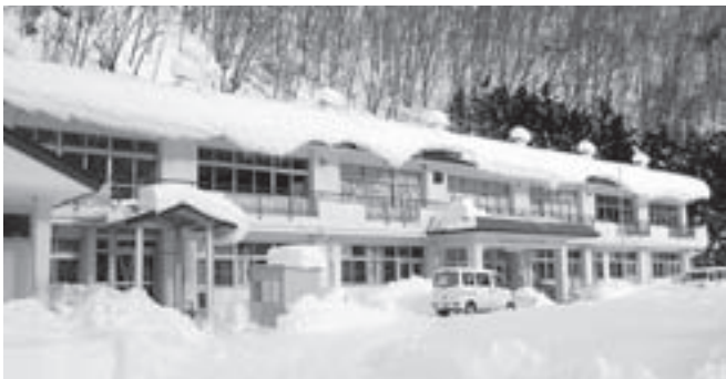
誠心会星野ショートステイ事業所「すみれ荘」として、活用されている旧星野小学校の校舎
