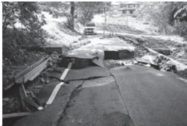
台風15号の大雨により流失した町道冠者沢線
