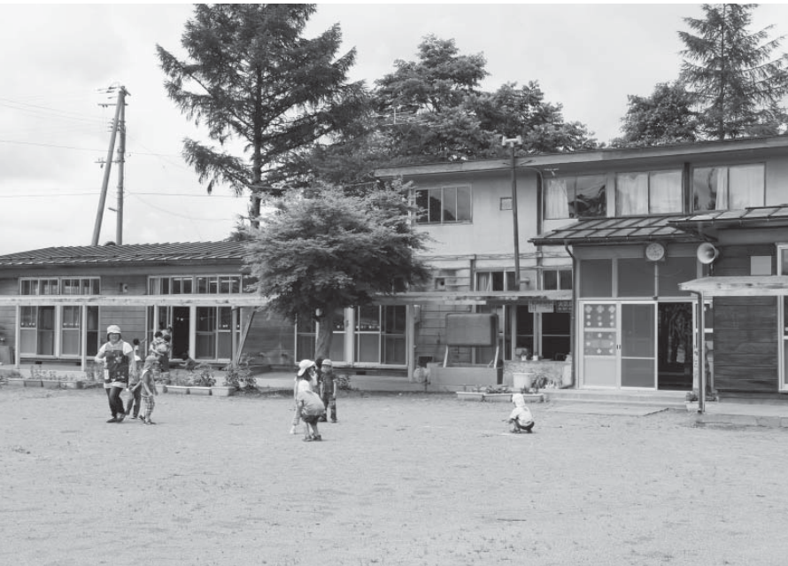
老朽化が進んでいる五日市保育園
