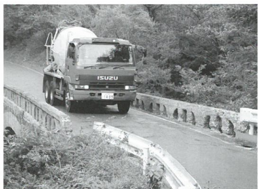
補強工事が予定される青刈橋(一戸町境)
