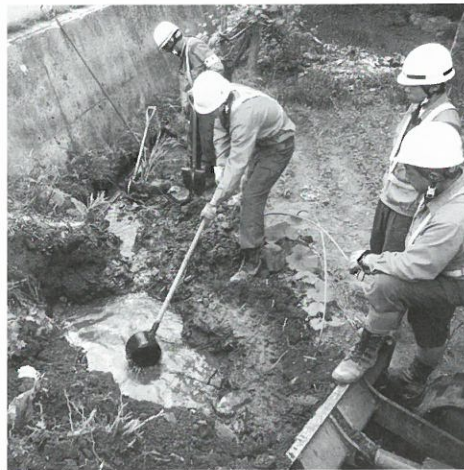
水道管の老朽化で江川地区の水漏れが増加（写真：岩脇地区）
