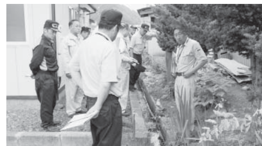
茶屋場地区の用水路の状況を確認する議員
